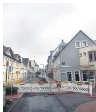
Die Knapper Straße ist nun zwischen Lessingstraße und Augustastrasse gesperrt.
